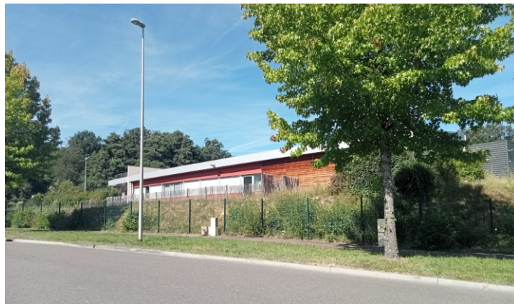
FIGURE 14 : BATIMENT ADMINISTRATION – VUE DEPUIS RUE BUGATTI (PRISE DE VUE : JUILLET 2022)
